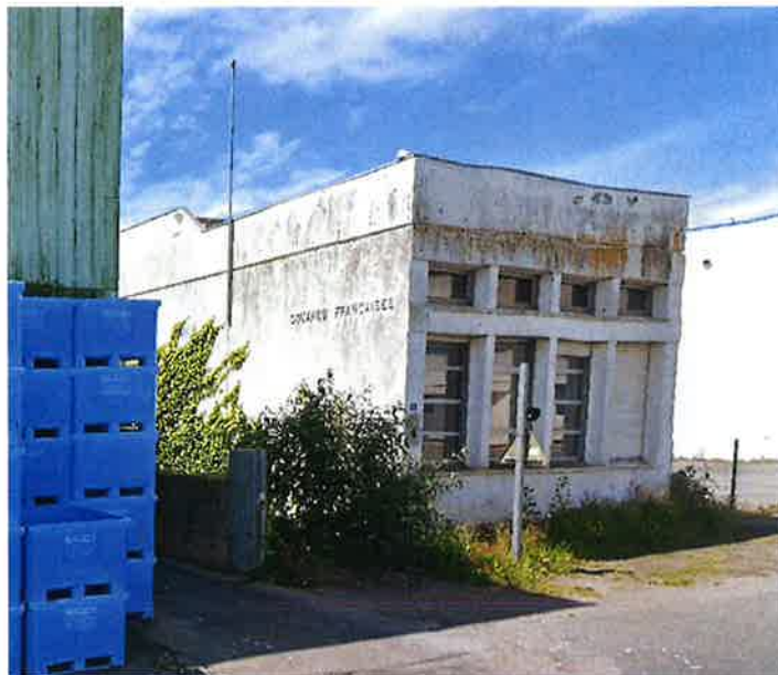
Vue a) bâtiment rue des Chalutiers
